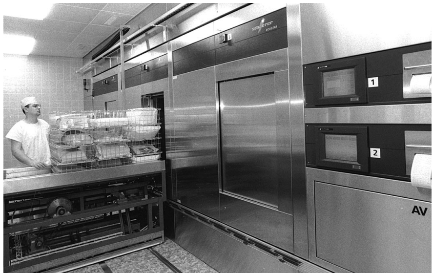
Abb. 7: Automatische Beschickung der Sterilisatoren.
